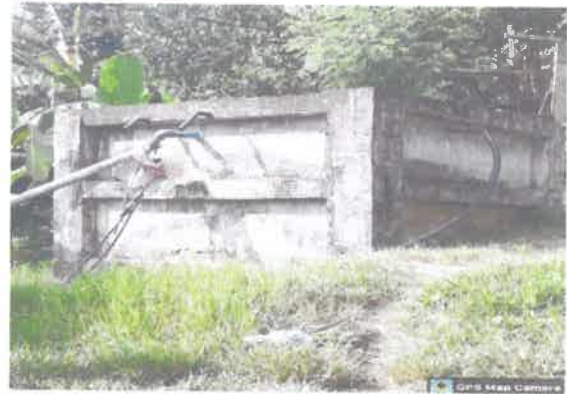
Masab-a (Barraks) 343 cubic meter reservoir.
