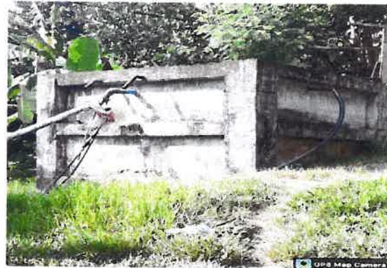
Masab-a (Barraks) 343 cubic meter reservoir.
